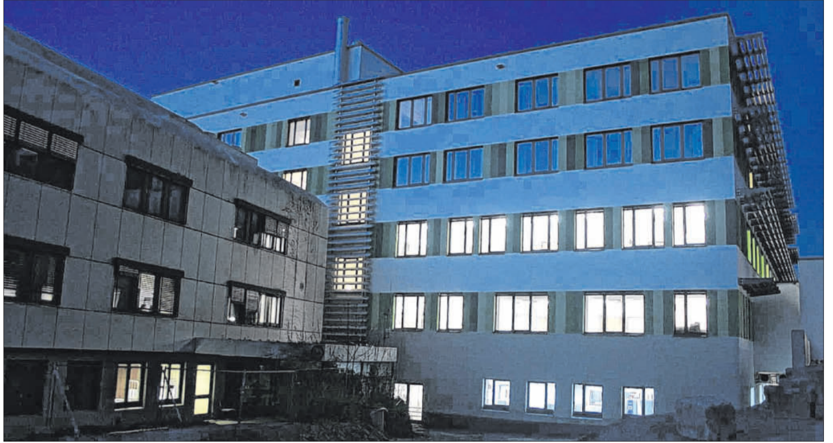
Ein Foto mit Symbolcharakter: Im neuen Crailsheimer Krankenhaus sind schon die Lichter an, während es im bisherigen OP-Trakt (links), der im Lauf des Jahres abgerissen wird, bereits dunkel ist. Am 17. Juni nimmt das gestern eingeweihte Klinikum seinen Betrieb auf. Heute ist Tag der offenen Tür. Foto: Andreas Harthan
